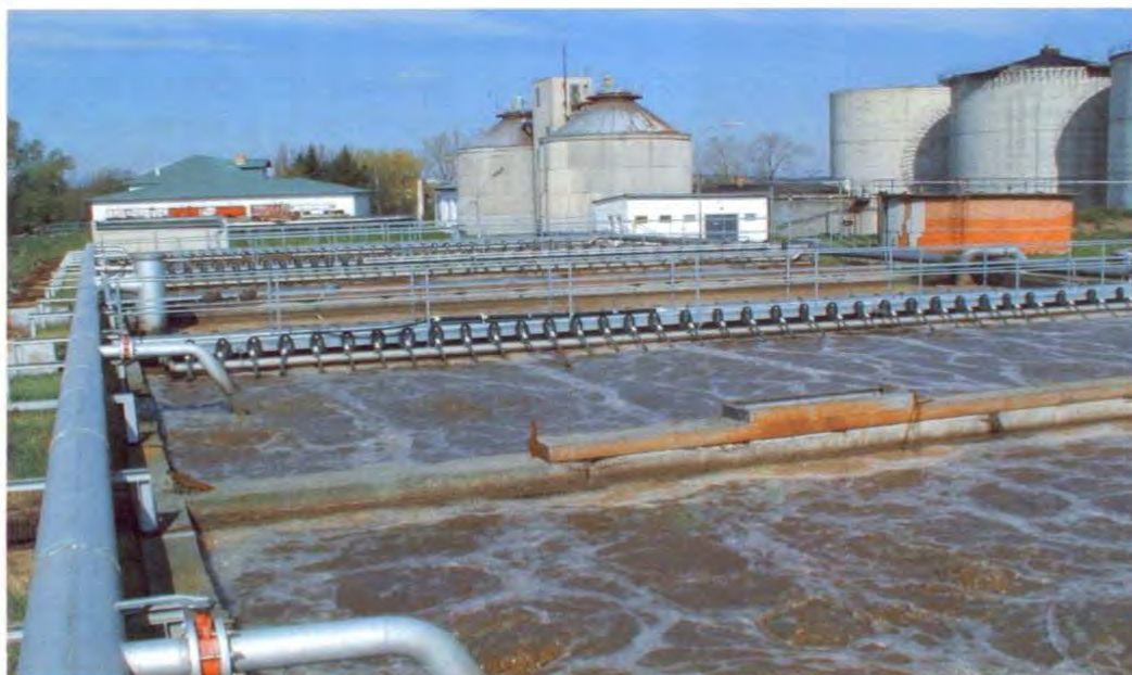
Čistiareň odpadových vôd
