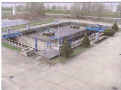
Čistiareň odpadových vôd
